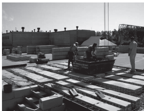
Рис. 5. Способы подачи бетонной смеси: а – механический; б – ручной
