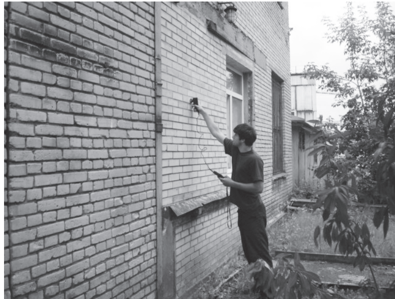
Рис. 3. Испытываемый фрагмент стеновой конструкции
