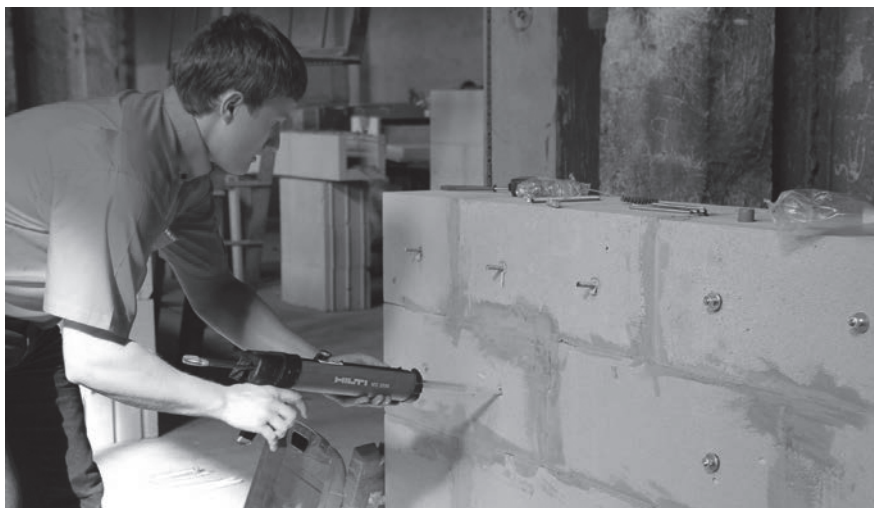
Рис. 3. Установка химического анкера
