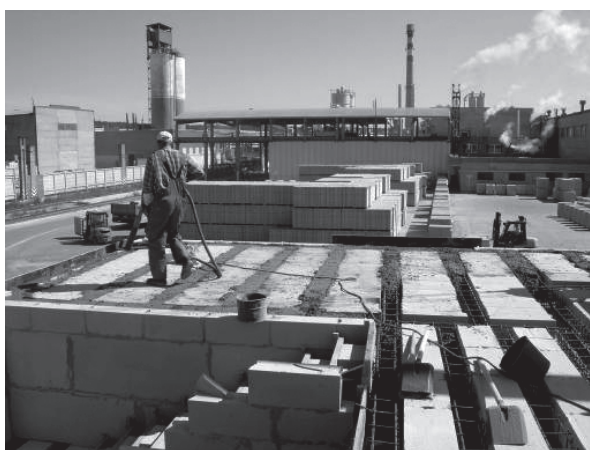
Рис. 5. Способы подачи бетонной смеси: а – механический; б – ручной
