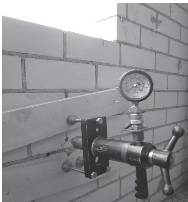
Рис. 11. Общий вид работы тестера по вырыву дюбеля из кирпичной кладки
