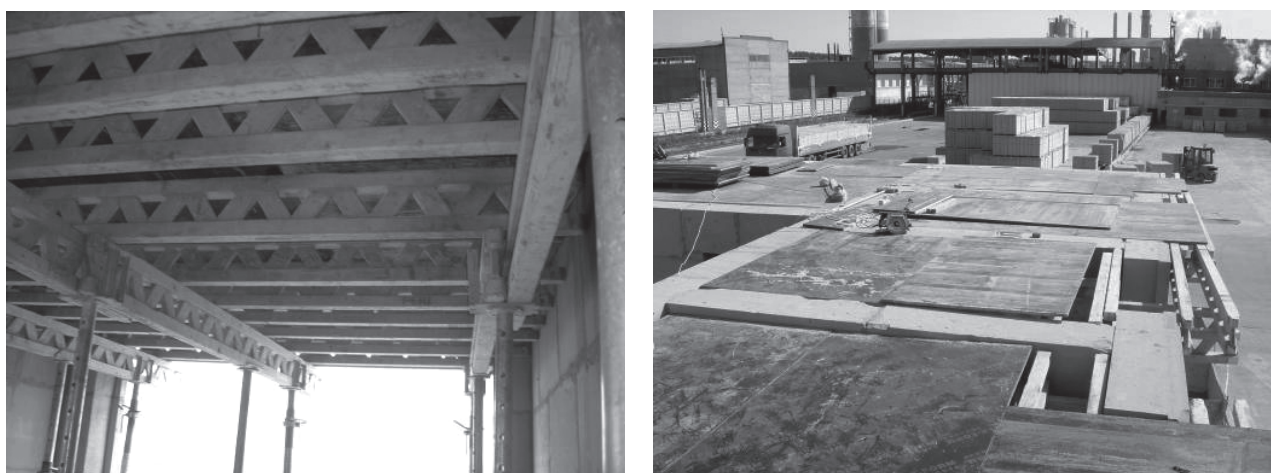
Рис. 1. Монтаж ферм деревянных ( а ) и укладка плит ЦСП ( б )
