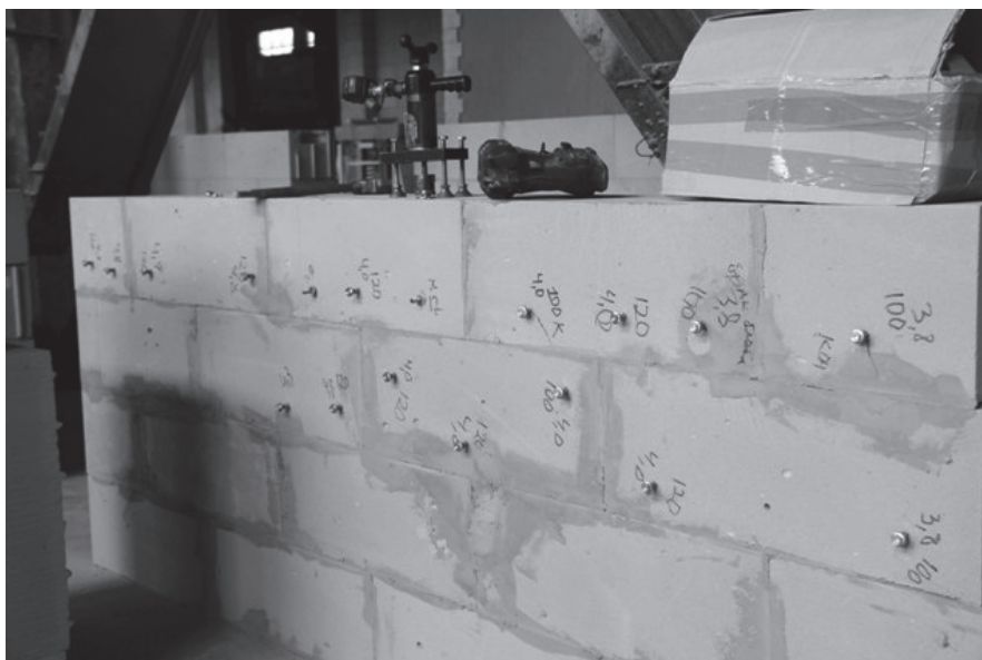
Рис. 2. Фрагмент кладки из твинблоков ТБ 300-5п в процессе испытаний
