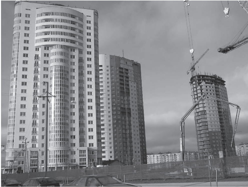
Рис. 1. Комплекс 22-этажных жилых домов с несущим каркасом из монолитного железобетона и поэтажно опертыми стенами из ячеистобетонных блоков в микрорайоне «Каменная горка-1» в г. Минске
