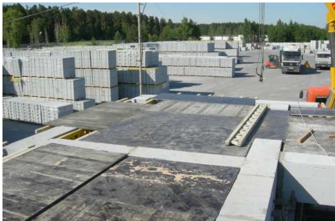
Фото 4. Вид перекрытия перед укладкой твинблоков
