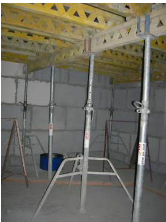
Фото 1. Применение инвентарной съемной опалубки
