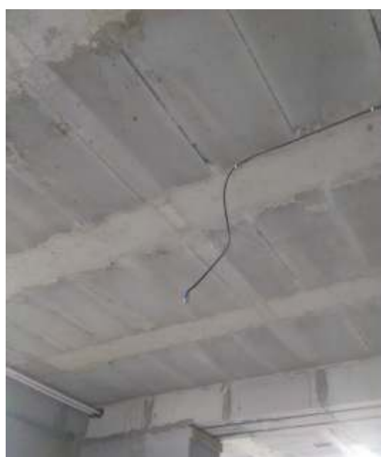
Фото 9. Вид снизу готового сборно- монолитного перекрытия
