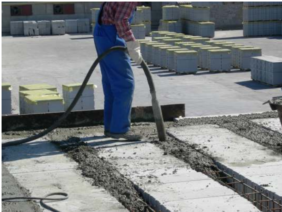
Фото 7. Укладка бетона
