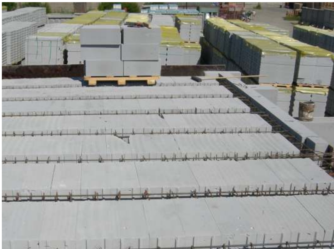
Фото 5. Вид перекрытия перед укладкой бетона
