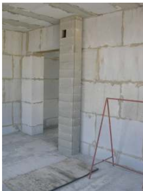
Фото 8. Вид снизу готового сборно- монолитного перекрытия
