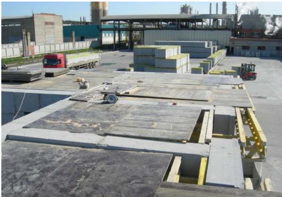
Фото 3. Укладка ламинированной фанеры на балки GT инвентарной опалубки
