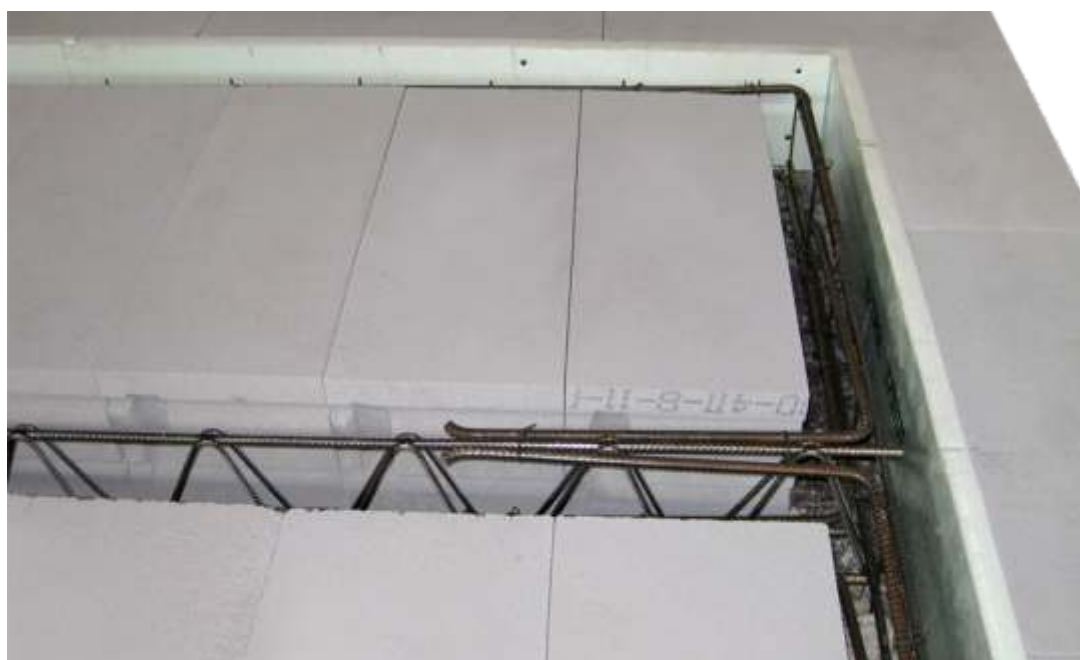
Фото 6. Вид перекрытия перед укладкой бетона
