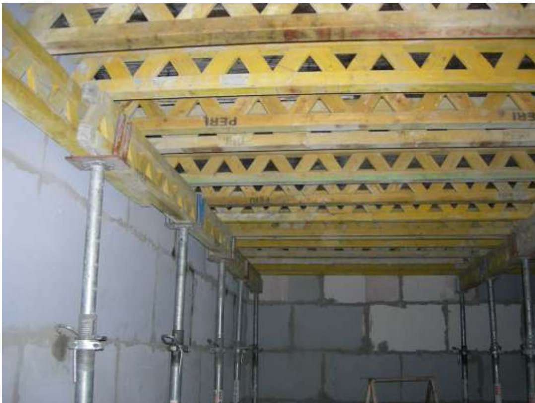
Фото 1. Применение инвентарной съемной опалубки
