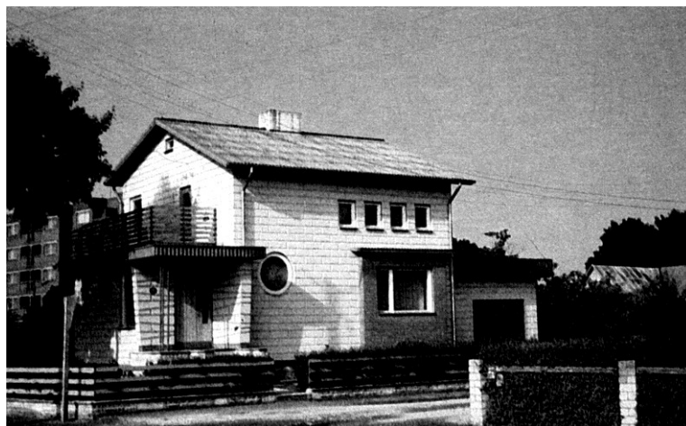
Рис. 6. Малоэтажный газобетонный дом с расшитыми швами без отделки
