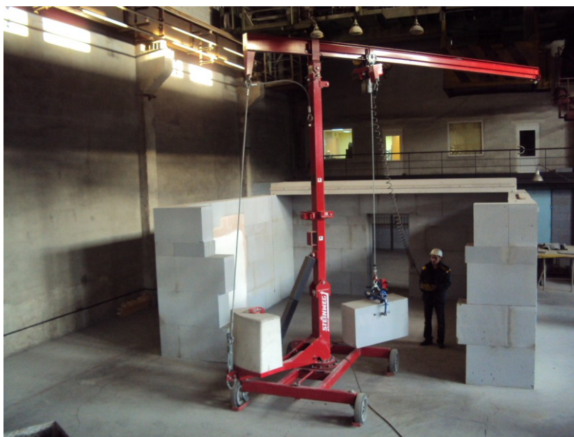
Рис. 2. Монтаж укрупненных твинблоков с использованием мини-крана
