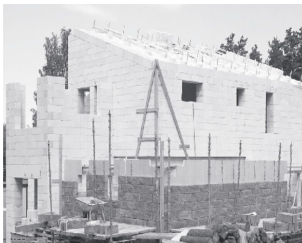
Рис. 2. Дом из газобетона
