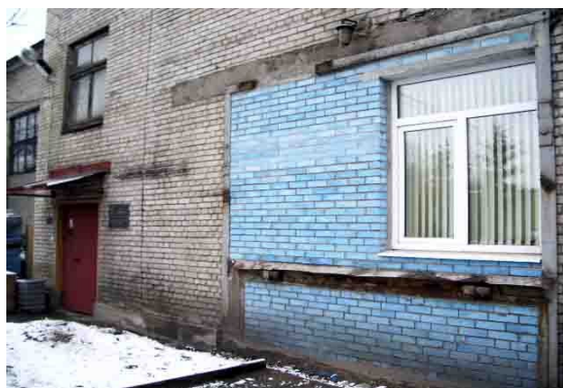
Рис. 2. Встроенный фрагмент стеновой конструкции
