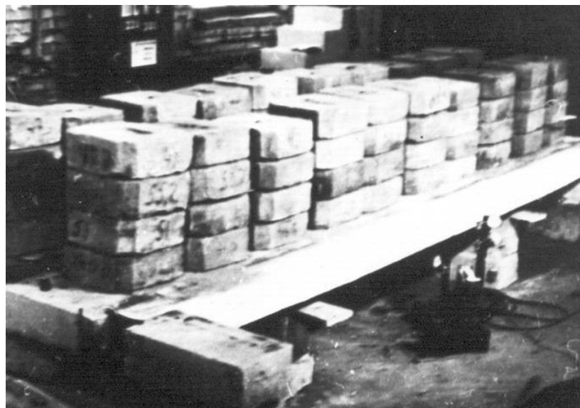
Рис. 2. Испытание сборно-монолитного перекрытия
