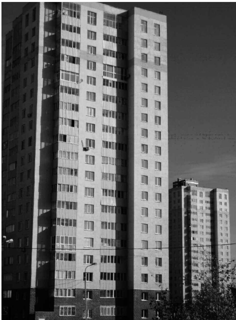
Рис. 1. Многоэтажные жилые дома в м-не Сипайлово г. Уфы с наружными стенами из автоклавных газобетонных блоков и фасадной отделкой в виде декоративно-защитного покрытия из материалов системы «Баумит»
